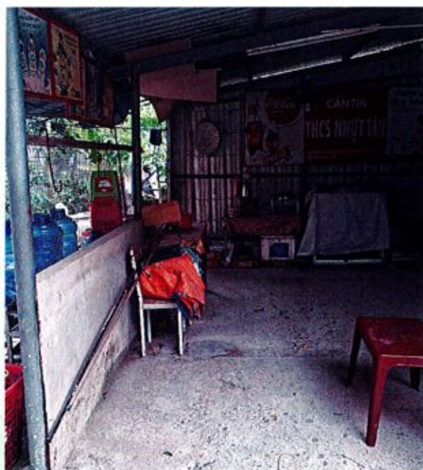
Hình 10: Hiện trạng, kết cấu căn tin
