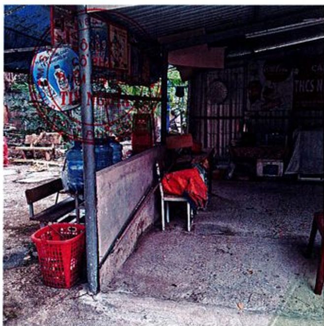
Hình 9: Hiện trạng, kết cấu căn tin
