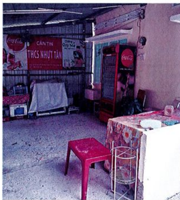
Hình 8: Hiện trạng, kết cấu căn tin
